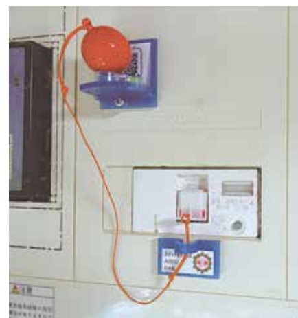
簡易タイプ感震ブレーカーの例
