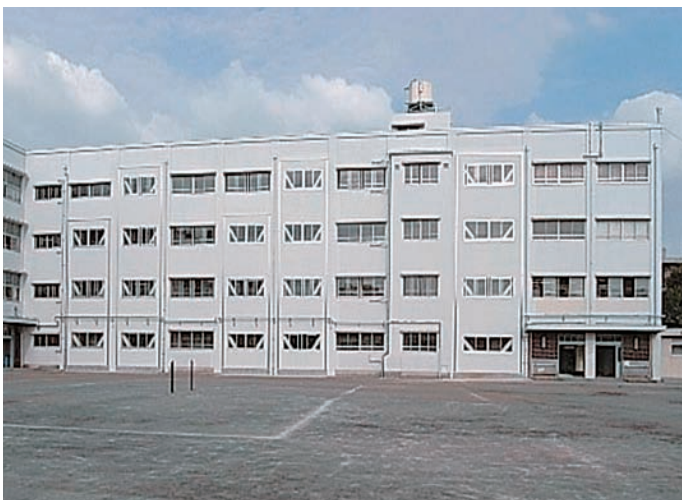
耐震化工事が完了した中学校校舎
