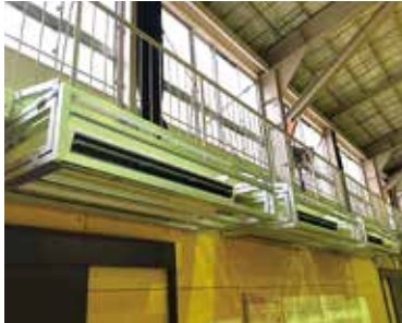
日吉南小学校体育館のエアコン設置
