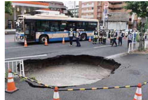
2022年に起きた港北区の道路の陥没
