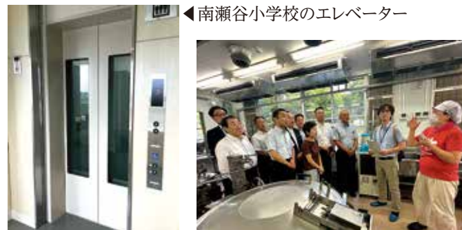
南瀬谷小学校のエレベーター
