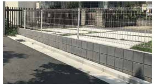
[新設フェンス]
