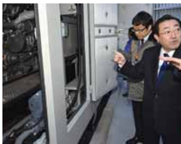
コージェネレーションシステム
