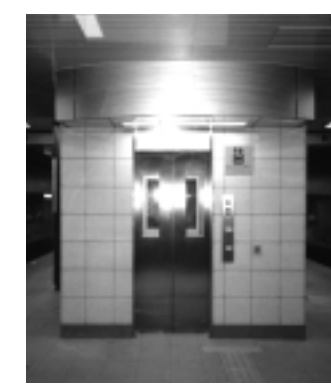
地下鉄東橋駅に設置されたエレベーター
